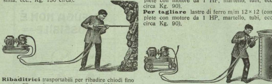
**Ribaditrici** trasportabili per ribadire chiodi fino a m/m 28 con interruttore speciale nell'impugnatura del martello che mette in marcia ed arresta contemporaneamente macchina e martello a volontà dell'operatore, consumando così energia solo al mo-
